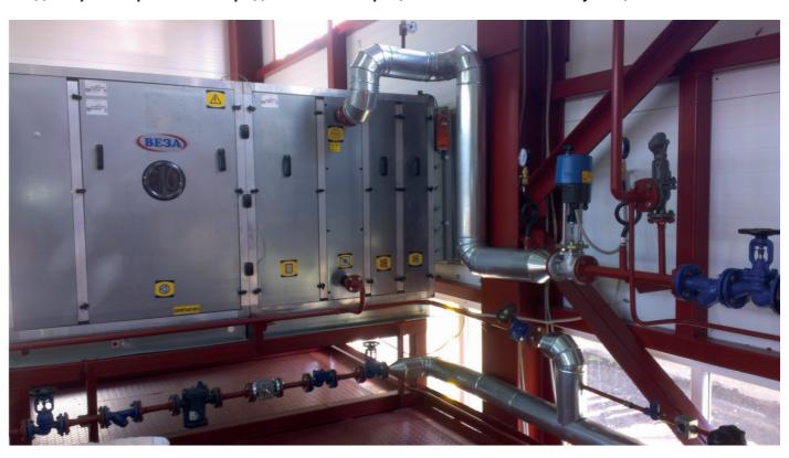
Приточные установки с паровым нагревом в комплекте с обвязкой и ШСАУ ВЕЗА введены в эксплуатацию на таких объектах, как:
