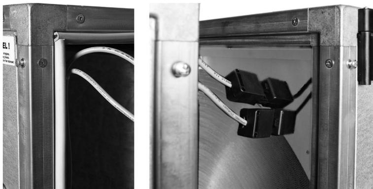
Установка секции охлаждения на другие агрегаты осуществляется с помощью устройства Disc-lock и сборочных фитингов для наиболее крупных агрегатов. См. инструкции по установке агрегата. Детали для сборки поставляются в комплекте с агрегатом и находятся в ящике с другими деталями (сифон, ручка и т. п.). Убедитесь в том, что упаковочный материал между деталями находится на месте, а провода/вилки не повреждены. Одновременно можно соединить защелкивающиеся разъемы.
