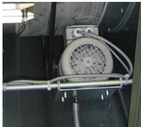
Привод ротора
