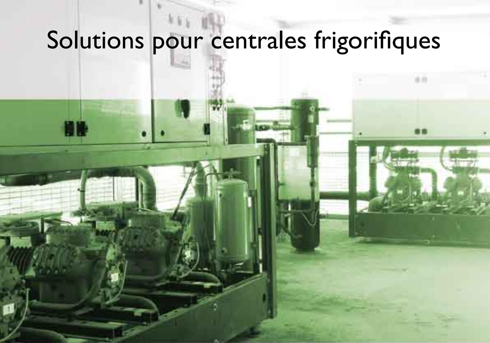
La centrale frigorifique est l'élément électromécanique le plus important et le plus complexe de l'installation frigorifique: de celle-ci dépend la génération de froid alimentaire pour tous les appareils frigorifiques et les salles de travail reliées.
